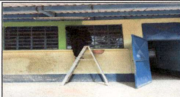
Foto 02: pintura en muros exteriores
