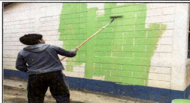
Foto 01: pintura en muros exteriores
