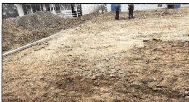
Foto 04: reparación de plancha de concreto de patio 10 centímetros de grosor
