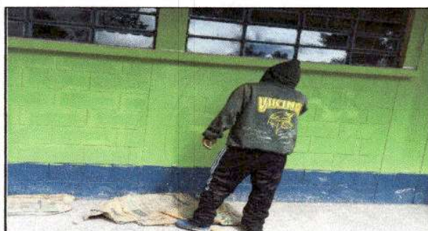
Foto 03: pintura de muros exteriores
